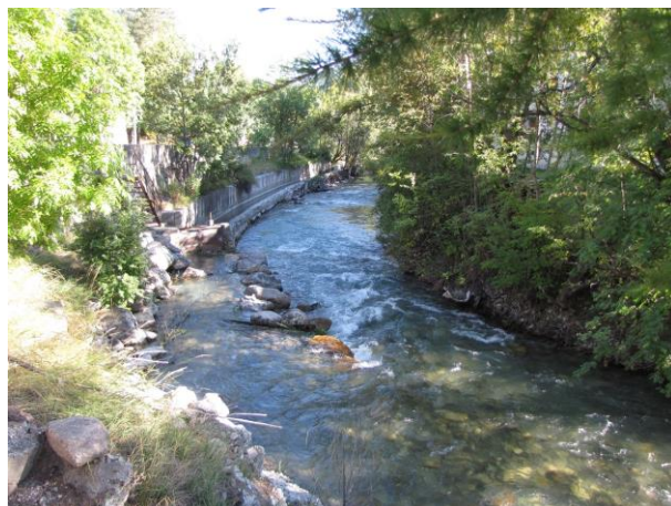
La prise d'eau du canal à Villeneuve-la-Salle
