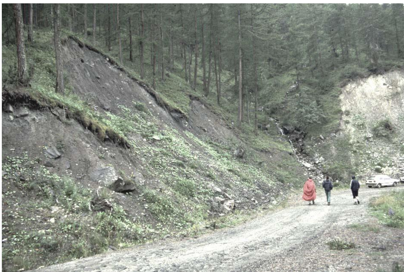
Cette photo prise dans le secteur du Prorel, montre des coupes dans des glissements de terrain.
