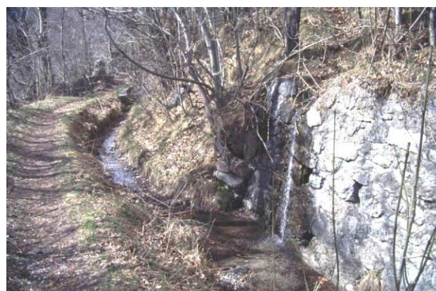
Arrivée d'eau dans le canal
