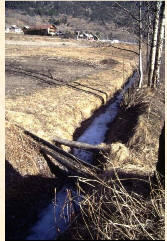
Intersection sur le canal Vieux de St Chaffrey.
