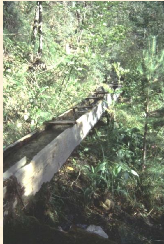
Caissons du canal des Reymondières.
