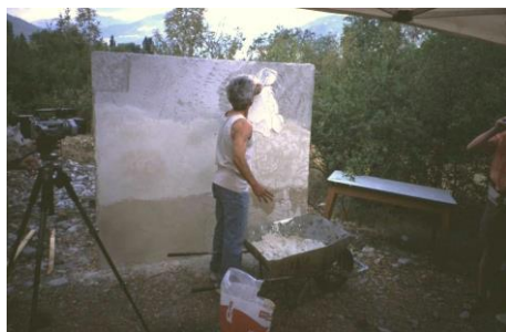
Utilisation de l'enduit à la chaux par N. PEYROT
