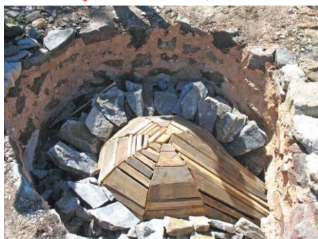
Coffrage pour la construction de la voûte
